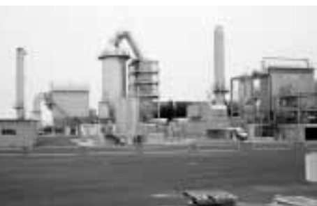
▲日量200tを処理する焼却炉 100tを処理する焼却炉がもう1基
