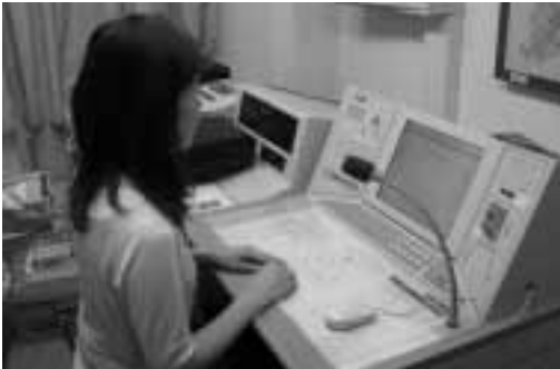
▲現在の防災行政無線設備
