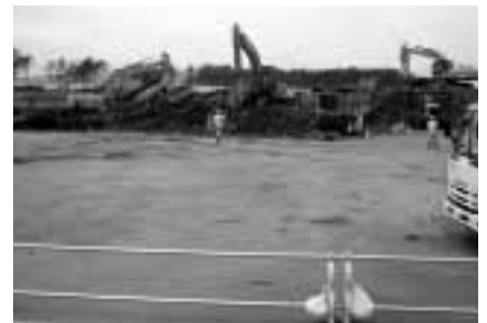
▲木くず破砕場 水洗浄も行います
