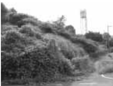
▲中国道法面の状況
