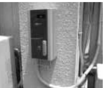
▲電気自動車充電設備（笹ヶ丘荘）
