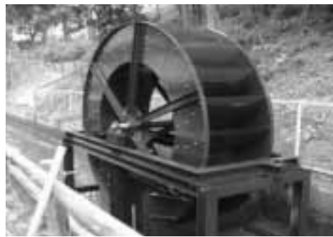
▲長野県松本市の小水力発電施設
