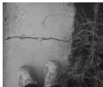
▲広がっている天端のひび
