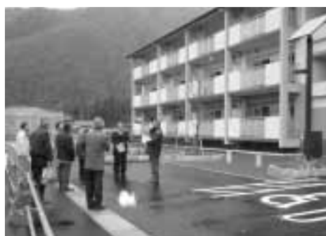
▲完成した久崎住宅を視察する産業建設常任委員(12月26日)
