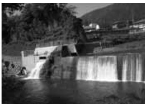
▲高知県梼原町の小水力発電所
