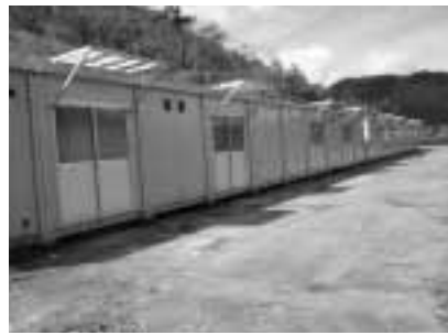
▲撤去前の久崎仮設住宅
