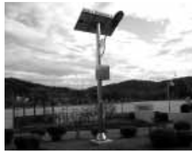
▲ソーラーシステム防犯灯 (佐用小学校)
