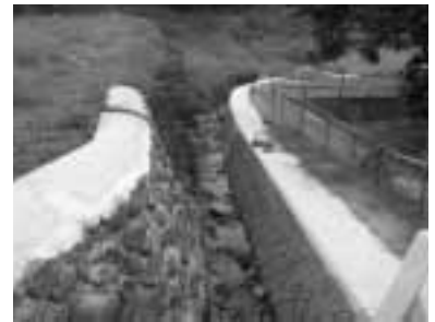
▲復旧工事の完了した被災河川
