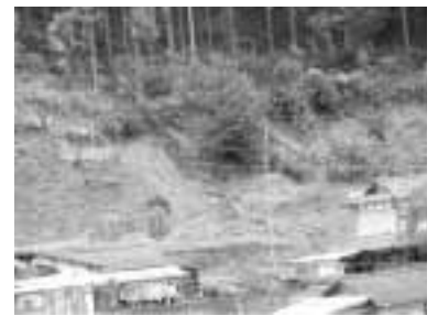
▲人家に近接する急傾斜地対策は防災上の緊急課題
