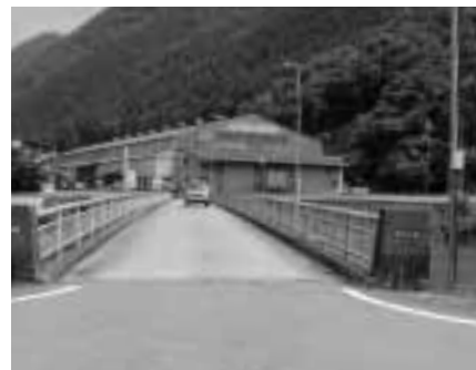
▲狭く、危険な小赤松橋
