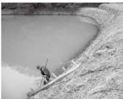
▲水位によって栓を抜いて排水するため池の「蜂の子」(写真手前部分)
