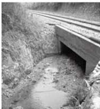
▲佐用町内濁流流入元となった 大山谷川姫新線カルバート
