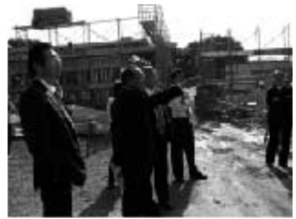
▲子育て支援センター建設現場
