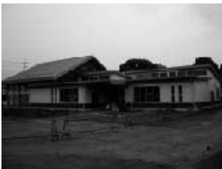
▲工事が進む子育て支援センター
