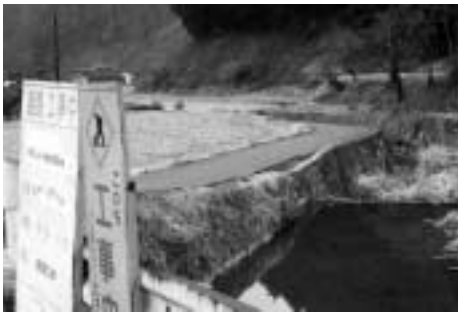
▲町道舗装修繕工事
