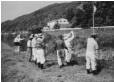
▲防護柵設置作業
