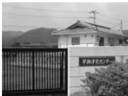
▲農業集落排水施設（早瀬浄化センター）
