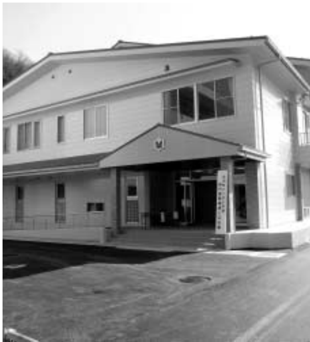
▲上月小学校屋内運動場
