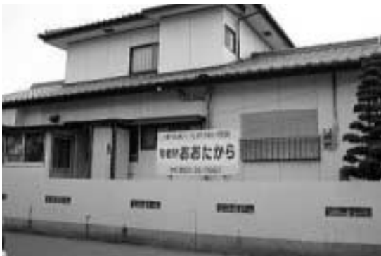
▲民家を改修した宅老所
