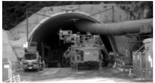
▲国道373号線（円光寺バイパス）道路改築事業
