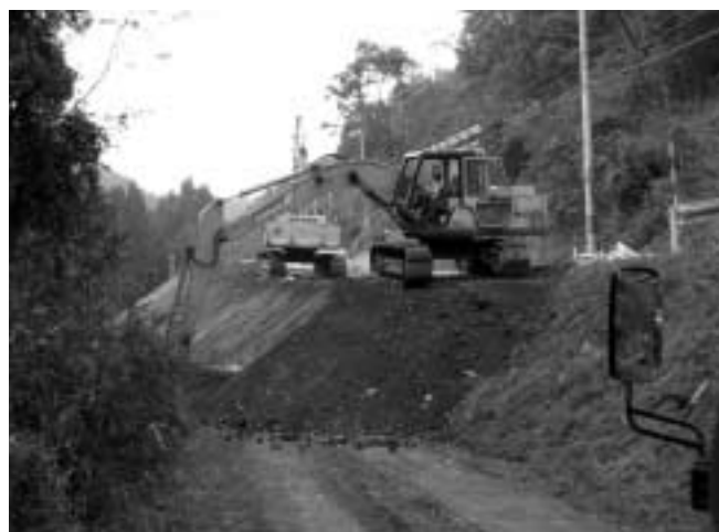
▲工事中の寺坂峠
