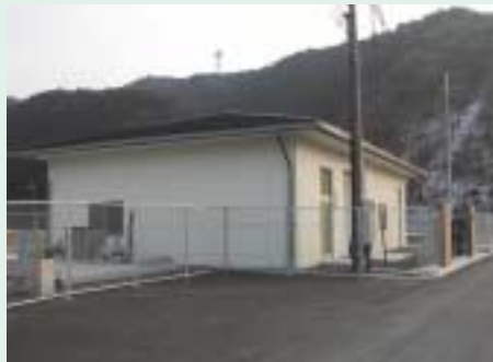
三日月浄水場
