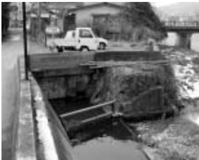
佐用中井取水樋門
