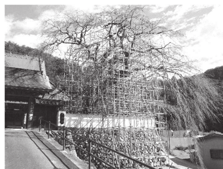
「光福寺の大イトザクラ」支柱設置
