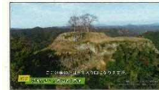
#02 登城禁止! 石垣崩落の危険 (R33分)
