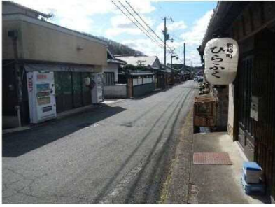
NO1 取り付け状況
