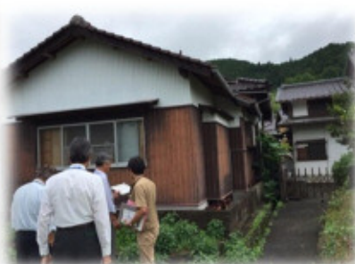
空き家調査の様子
