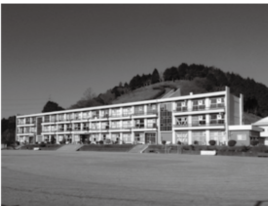
大規模改修が終わった三日月小学校
