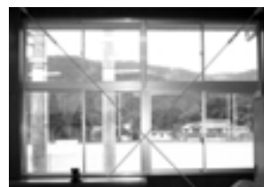
三日月中学校耐震ブレース
