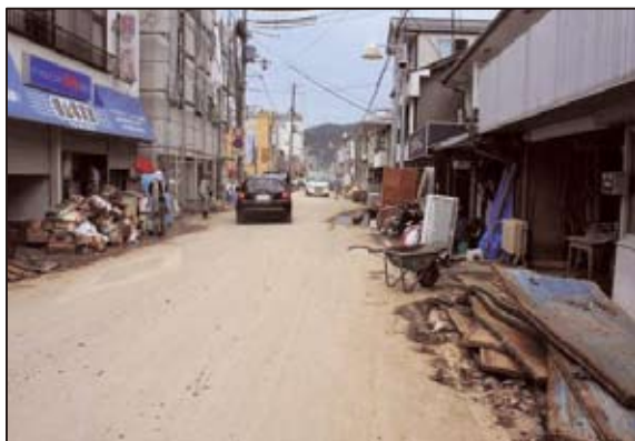
商店街の被害状況【佐用商店街】
