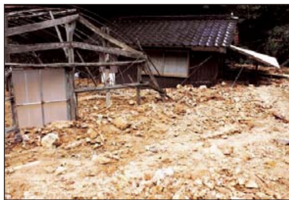
土砂の流出による家屋被害【海内】
