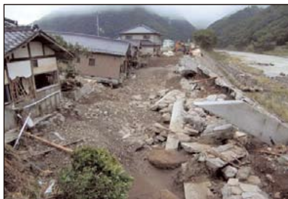
河川の氾濫による家屋被害【久崎】
