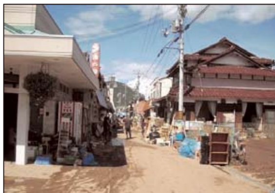
商店街の被害状況【久崎商店街】
