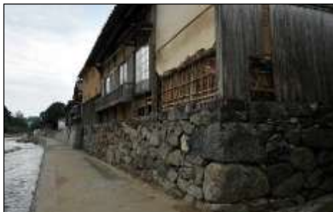
平福景観形成地区の被害状況
