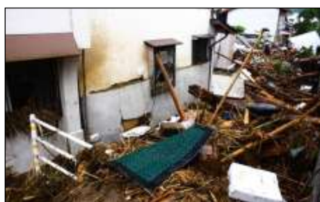
河川漂流物による家屋被害
