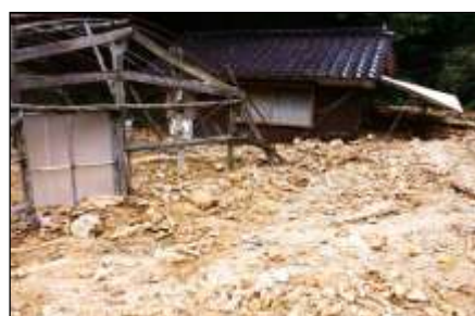
土砂による家屋被害
